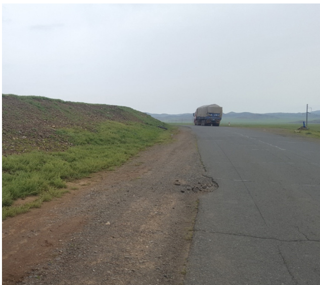
Зураг-14: Үзэгдэх орчин муу буюу тэлж ухах шаардлагатай ухмал. Ухмалын материалыг далан болон хөвөөнд ашиглах
