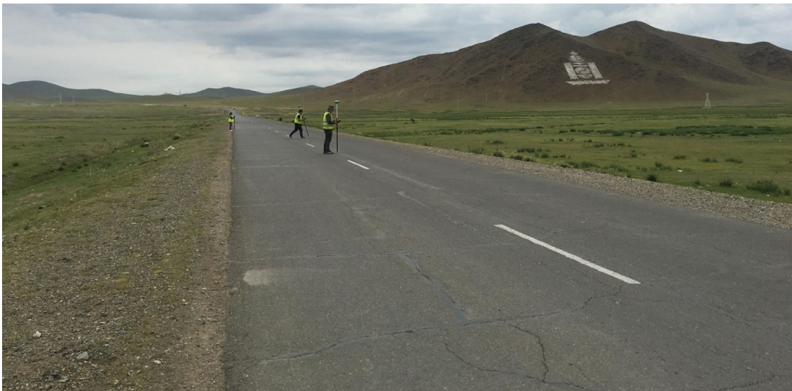
Зураг-11. Км397+600 Бага эвдрэлтэй хучилтын ерөнхий байдал
