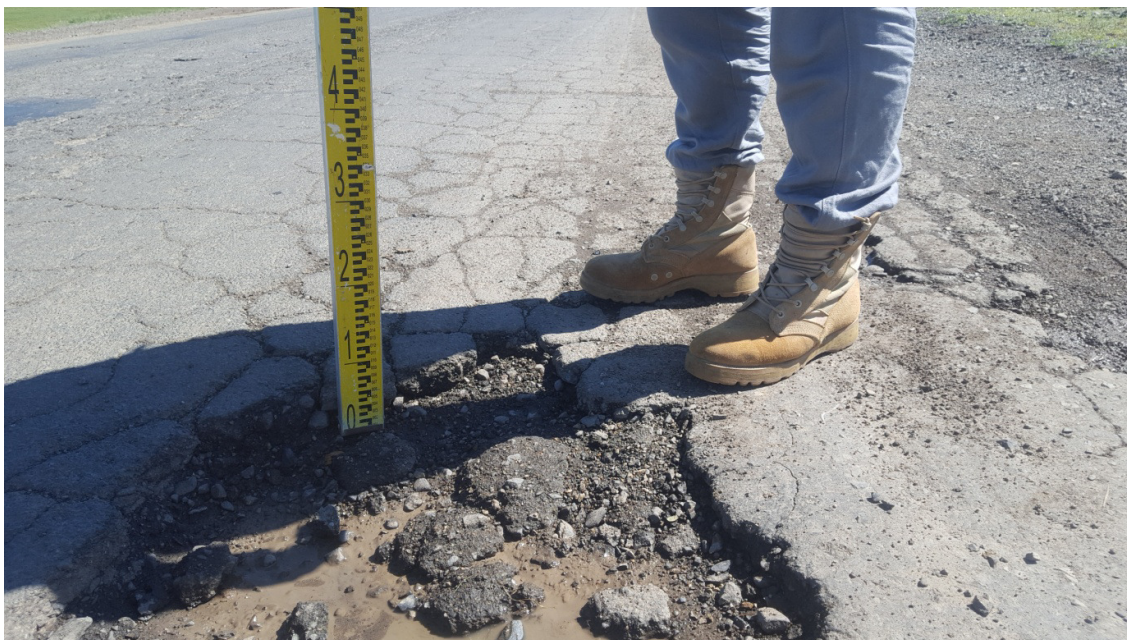
Зураг-2. Км388+020 Асфальтобетоны зузааныг шалгаж байна. /захын хэсэг/
